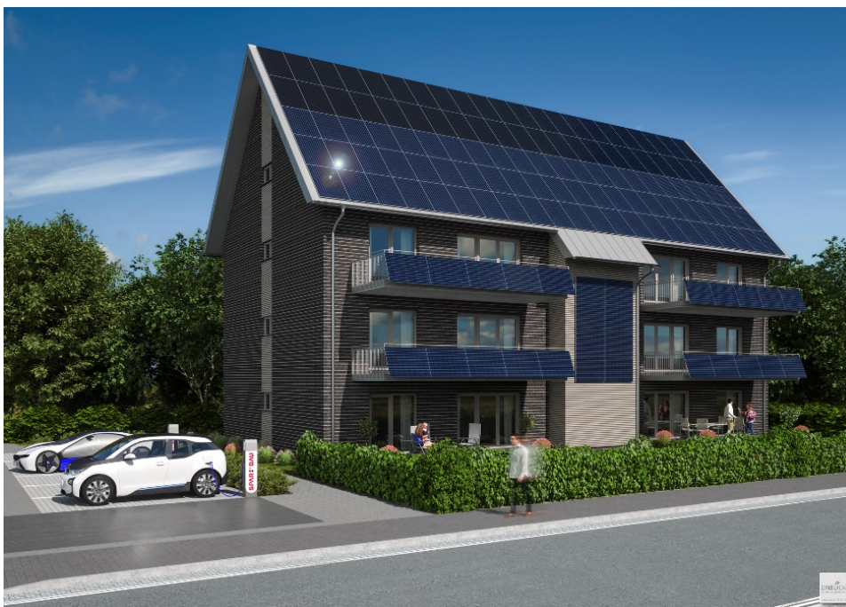
& Abb. 12: Mieten mit Energieflat: 6 Wohneinheiten in einem energieautarken Mehrfamilienhaus in Wilhelmshaven, Fertigstellung 2018. Solartechnik auf dem Dach und an den Balkonen mit Energiespeicher erreichen etwa 70 Prozent solare Deckung des Strom- und Wärmebedarfs. Auch hier: Vermietet mit Pauschalmiete für 10 Jahre, die Wohnen, Wärme, Strom und E-Mobilität als Flatrate enthält. Bildquelle: Wilhelmshavener Spar- und Baugesellschaft eG
