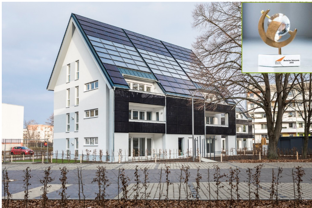
↗ Abb. 14: Zwei energieautarke Mehrfamilienhäuser in Cottbus. Quelle HELMA. Dieses Projekt wurde mit dem Deutschen Solarpreis 2018 geehrt. Quelle Eurosolar
