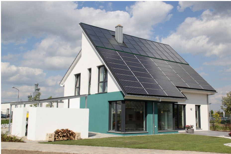
➤ Abb. 3: Erstes bezahlbares energieautarkes Eigenheim Europas als unbewohntes Musterhaus in Lehrte/Hannover von der HELMA Eigenheimbau AG Baujahr 2011. Es versorgt sich selbst mit Wärme, Strom und E-Mobilität: durch Solarthermie (mit Langzeitwärmespeicher), Photovoltaik (mit Akku) sowie etwas Biomasse. Primärenergiebedarf: 7 kWh/m 2 a.
