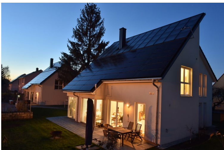
➤ Abb. 4: Die ersten beiden bewohnten energieautarken Einfamilienhäuser Europas in Freiberg/Sachsen, errichtet 2013 von der HELMA Eigenheimbau AG, Häuser, die zur Tankstelle werden Bis 2016: umfassende messtechnische Untersuchung durch die TU Bergakademie Freiberg. Diese bestätigt, dass die Berechnungen und Simulationen korrekt sind. Intelligente Eigenversorgung mit Wärme, Strom und Mobilität aus der Sonne.
