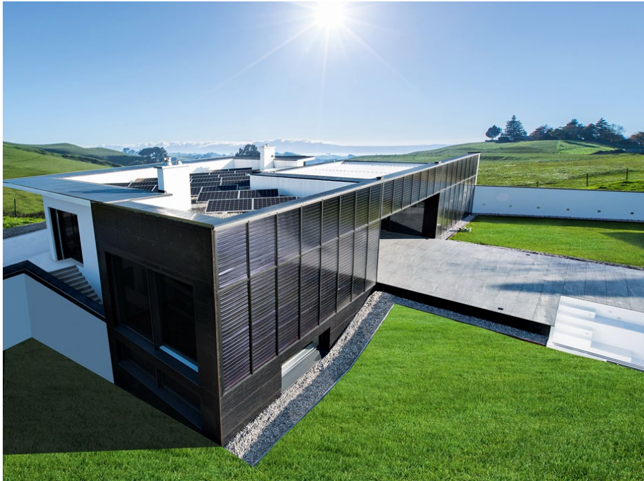
➤ Abb. 5: VitalSonnenhausPro der Firma Bauhütte Leitl-Werke GmbH: Das erste energieautarke – und barrierefreie – Gebäude Österreichs, Baujahr 2016 in Schwertberg/Oberösterreich. Bildquelle: Boris Maier/Bauhütte Leitl-Werke
